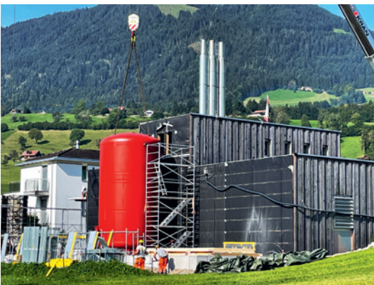
Platzierung des Speichers (Foto: Res Berchtold)
