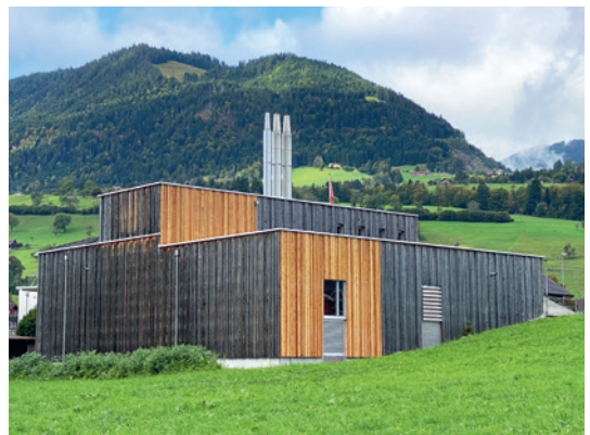
Gesamtansicht von Nordost (Foto: Hampi Lussi)
