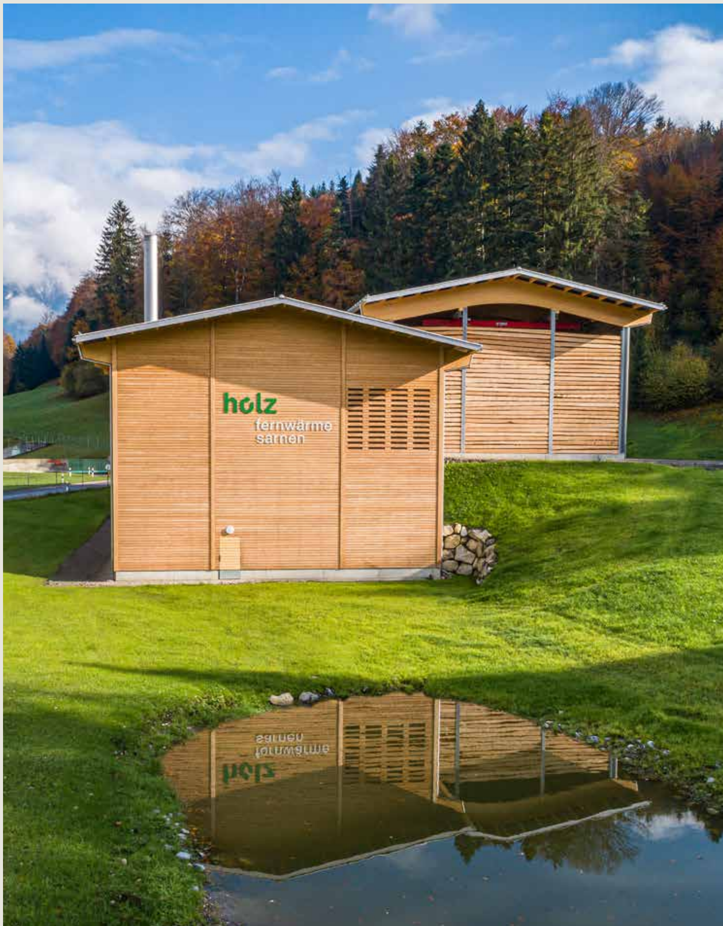
Heizwerk Foribach, Sarnen
