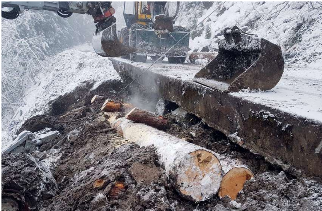
Verbauung Schneeloch: Fundament Strasse
